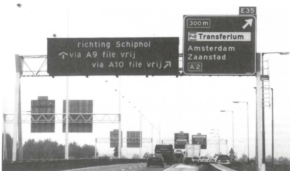
Dynamische Route Informatie Paneel (DRIP) in de omgeving van Amsterdam. Bron: Traffic Technology International, Annual Review '98.
